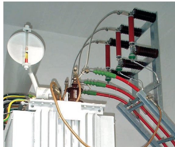
Bild 10 DEHNmid: Überspannungs-Ableiter für Mittelspannungssysteme
