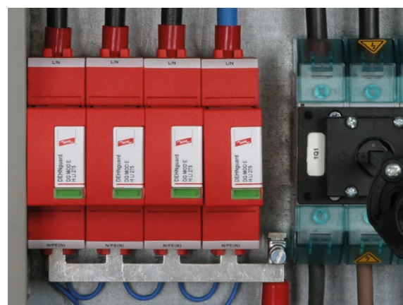
Bild 9 DEHNguard SE H LI: Überspannungs-Ableiter mit integriertem Frühwarnsystem „Lifetime Indication“
