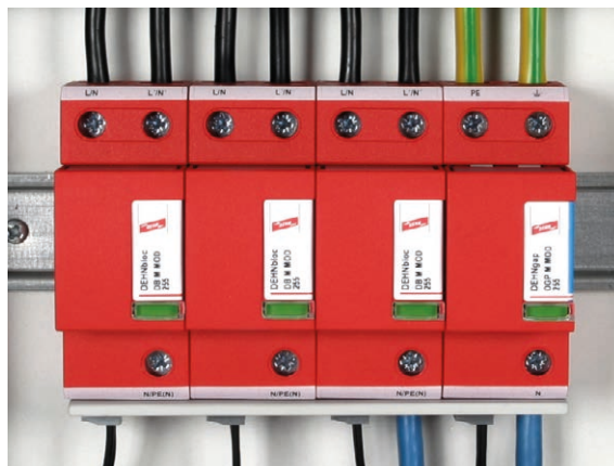
Bild 6 DEHNbloc modular: Koordinierter Blitzstrom-Ableiter auf Funkenstreckenbasis
